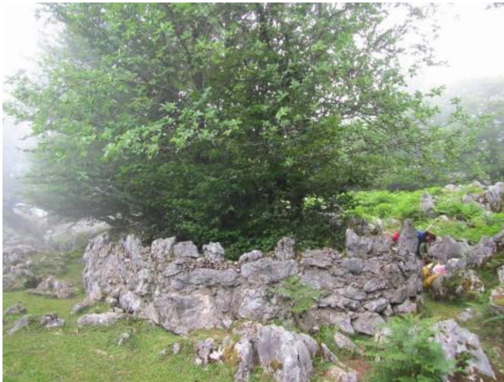
Muro del pozo de entrada
