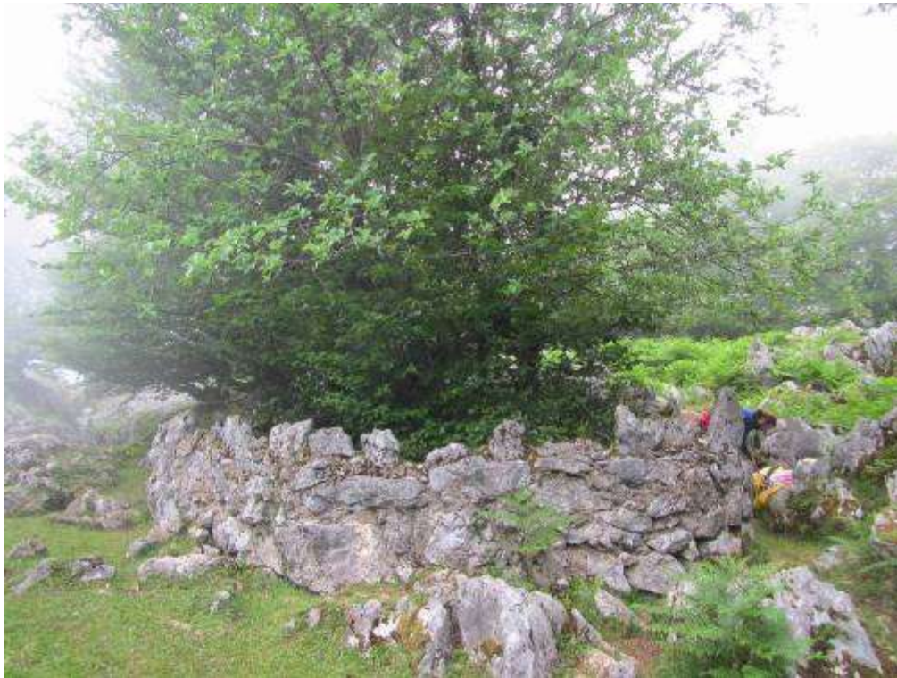
Muro del pozo de entrada
